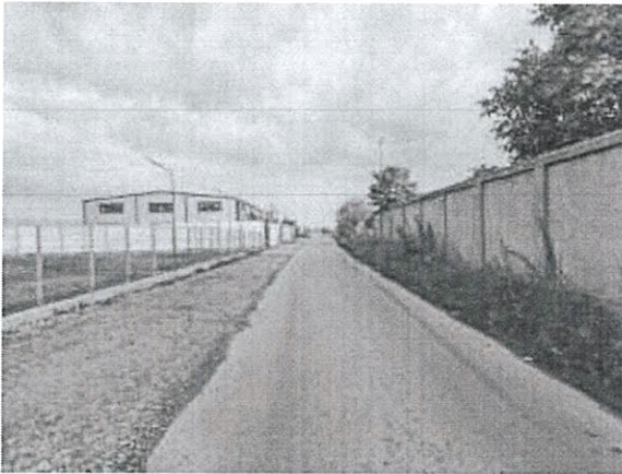
Strada Pădurii, km 0+020
