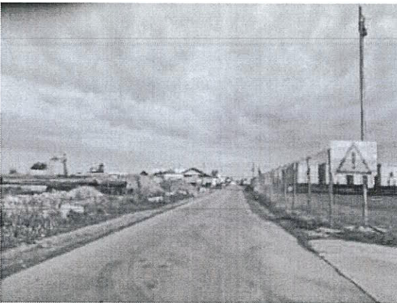
Strada Pădurii, km 0+400
