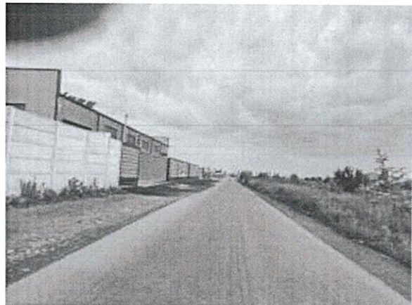
Strada Pădurii, km 0+160
