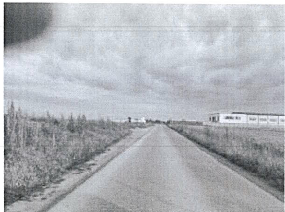
Strada Pădurii, km 1+100
